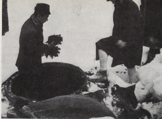
Betonski silos v zemlji z nepredušnim pokrovom za toplotno izolacijo Foto J. Čop
