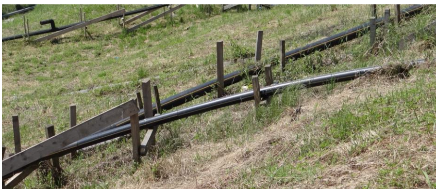
Slika 48: Plastične cevi za odvod plinov z leseno konstrukcijo, s katerih smo vzorčili iztrebke vran (foto: I. Jelenko Turinek, marec 2016).
