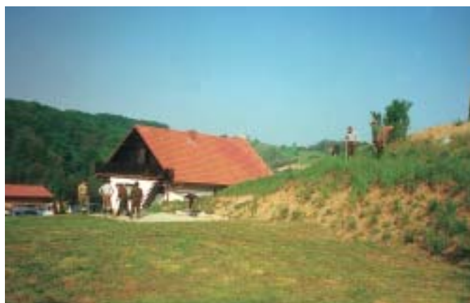
Preden so si na temelju porušene (kupljene) domačije zgradili svoj dom, so morali člani pošteno poprijeti za krampe in lopate. Opravili so več kot 1000 delovnih ur.
