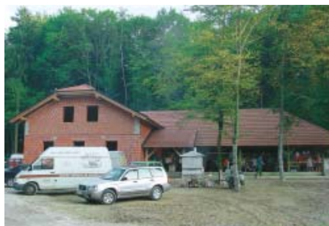
Lovski dom LD Vitomarci je zgrajen že do 4. gradbene faze.
