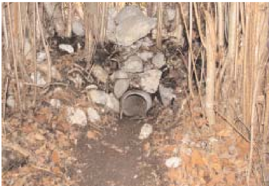
V nižinskih loviščih z manjšim deležem gozdov je ena od možnosti za jamarjenje tudi postavitve umetnih rogov. Ti so ponavadi narejeni iz betonskih cevi s premerom 20 cm in dolgi najmanj 8 m. Obstajajo rovi z enim ali z dvema vhodoma. Za jamarjenje so lahko enako zanimive tudi drenažne cevi na polju, ki jih lisice zelo rade obiskujejo.
