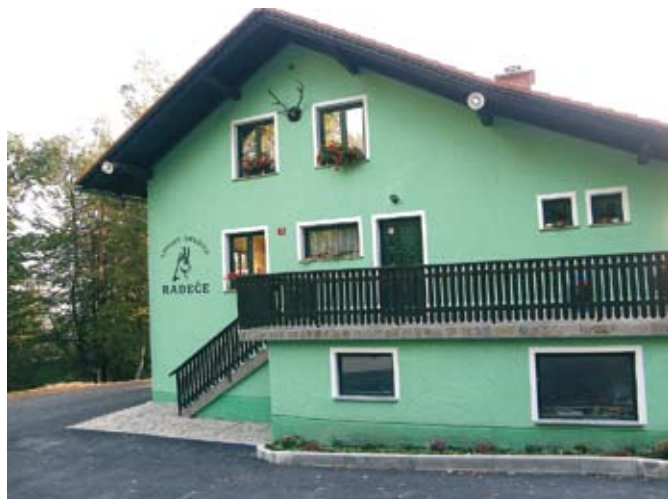
Obnovljen lovski dom LD Radeče je poleg lovcev na uporabo tudi občanom.
