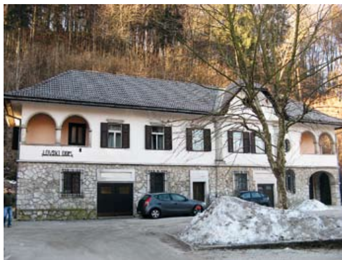
Lovski dom LD Kropa v Podnartu je spomeniško zavarovana stavba.
