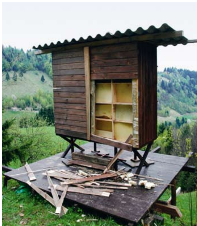
Čebelnjak, ki ga je poškodoval medved.
