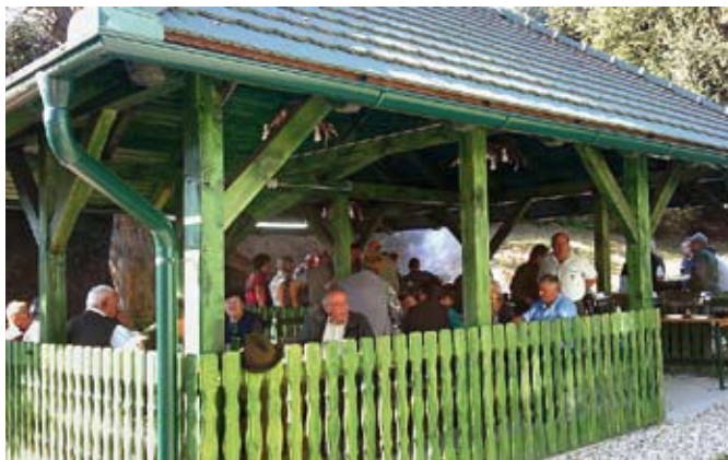
Lovci LD Gornja Radgona so za izdelavo lesenega nadstreška in druga opravila opravili 450 neplačanih ur lesarskih, električnih, gradbenih, krovskih ter drugih del.
