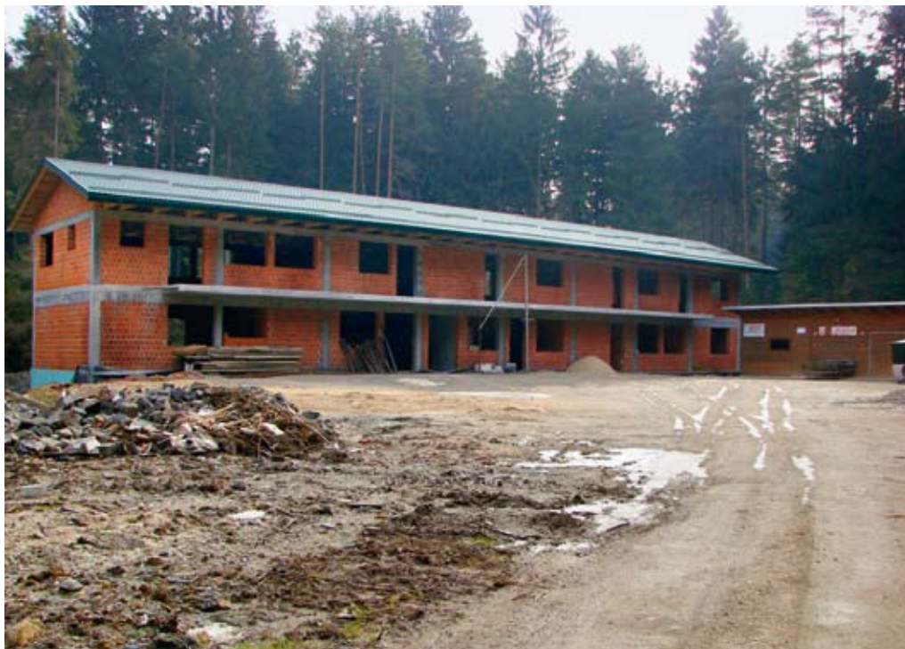
Gradnja novega objekta Puškarstva Skobir nad Slovenj Gradcem, kjer bodo urejeni tudi večnamensko podzemno strelišče in klubski prostori.
