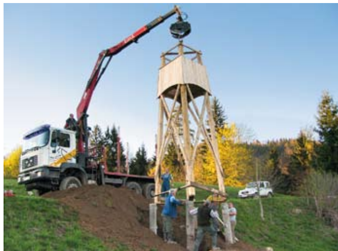
Dvig in nameščanje prej narejene visoke preže na betonske podstavke
