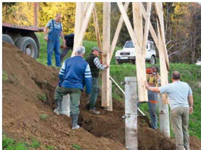
Pričvrstitev lesenih nosilcev preže na betonske podstavke
