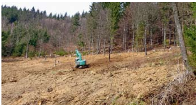
Strojno poravnavanje pašne površine z bagrom
