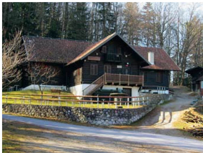
Lovski dom LD Prebold na Golavi pred obnovo
