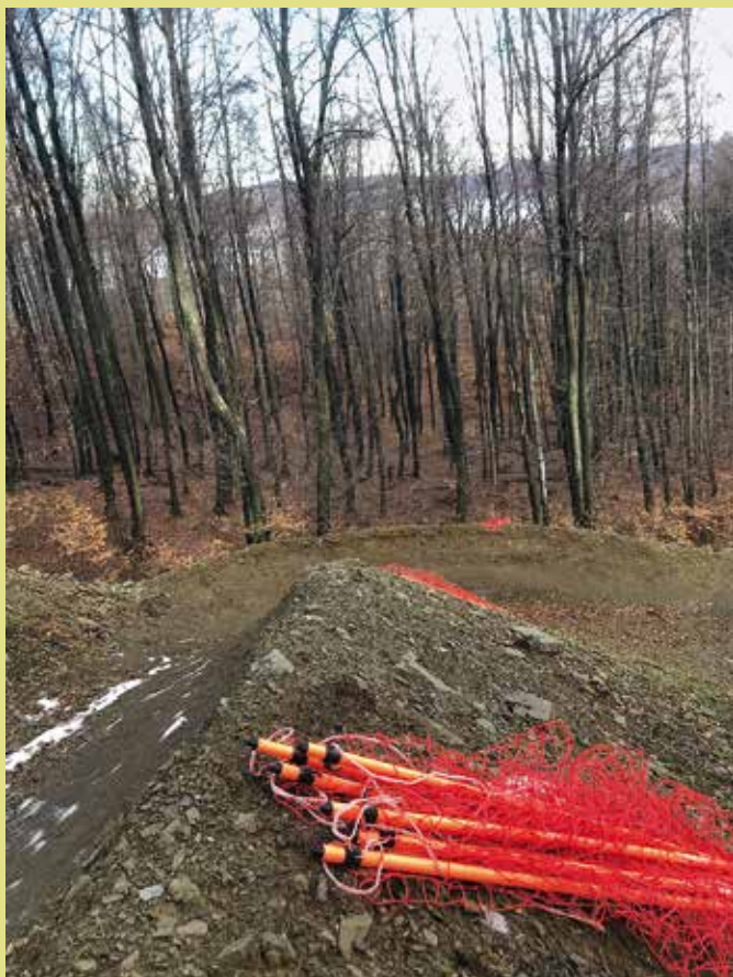
Ob umetnih nasipih, speljanih za »kolesarsko progo«, in nekaj požaganih drevesih ni niti enega naravnega prehoda za divjad, temveč povsem nenaravna oranžna plastična ograja.
