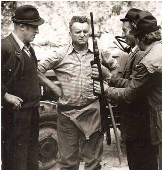
Utrinek z gradnje strelišča. V sredini je takratni starešina LD Šentlambert Franc Ocepek.
