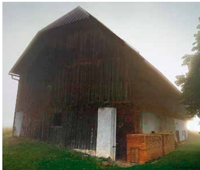
Pogled na skedenj pred obnovo ...
