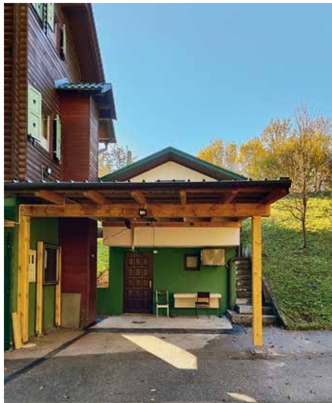
Prenovljena hladilnica LD Makole z nadstreškom
