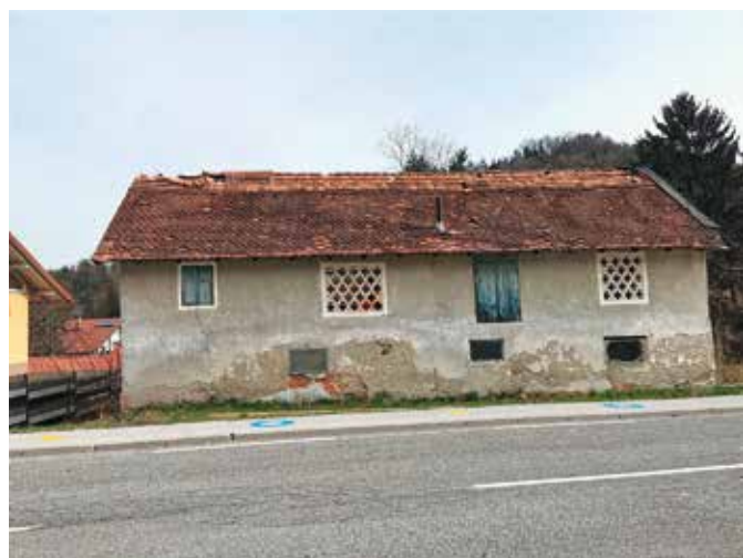
Lani se je LD Prebold ponudila priložnost za nakup opuščenega hleva s precej velikim parkiriščem v gornjem Preboldu. Po porušenju bomo na tem mestu zgradili družinsko prevzemnico za uplenjeno divjad in hladilnico.
