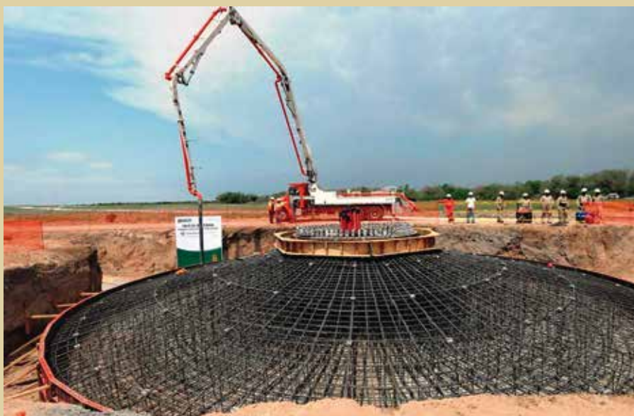
Slika 3: Primer gradnje temeljev vetrne elektrarne (https://www.naiz.eu/eu/info/noticia/20220317/aprobada-la-ley-navarra-de-cambio-climatico-que-delimita-zonas-para-parques-eolicos-y-solares)
